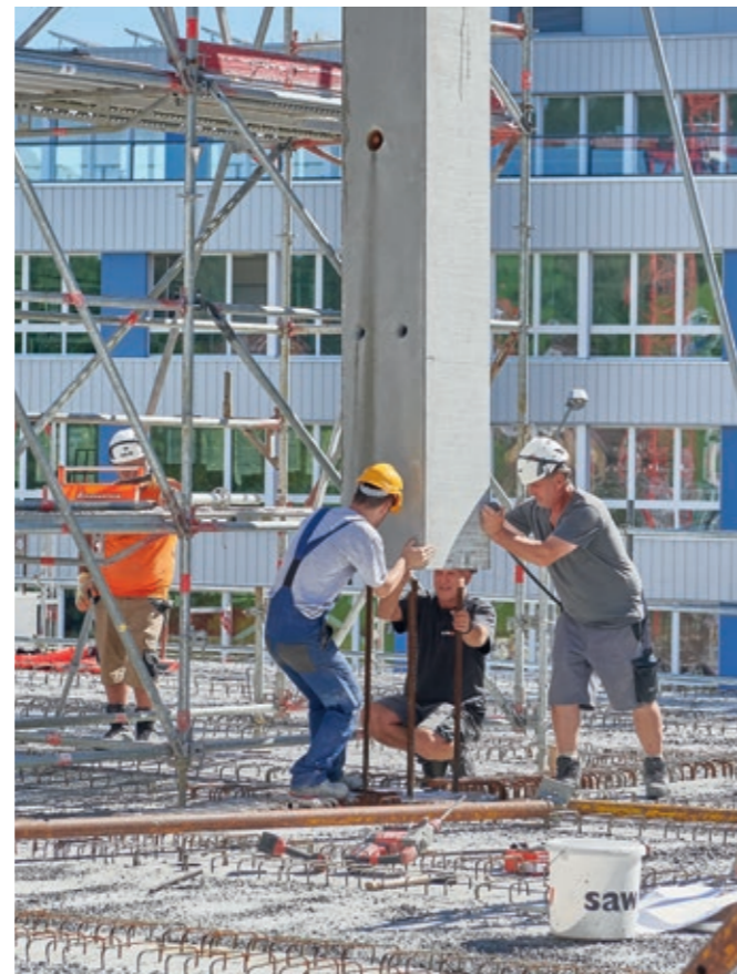
Stützenfuss mit Anschlussbewehrung aus der Bodenplatte*
