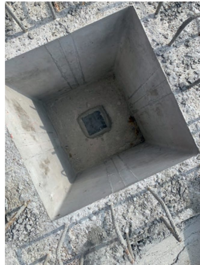
Stützenfuss mit Köcherfundament*
