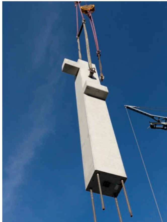
Stützenfuss mit Anschlussbewehrung aus der Stütze*
